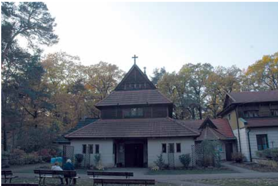
Kaplica pod wezwaniem Matki Bożej Anielskiej, zbudowana w 1925 r. na terenie Zakładu w Laskach
